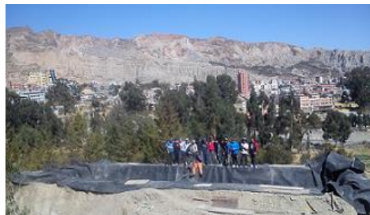
Figura 7. Extendido y acomodado de la geomembrana.
