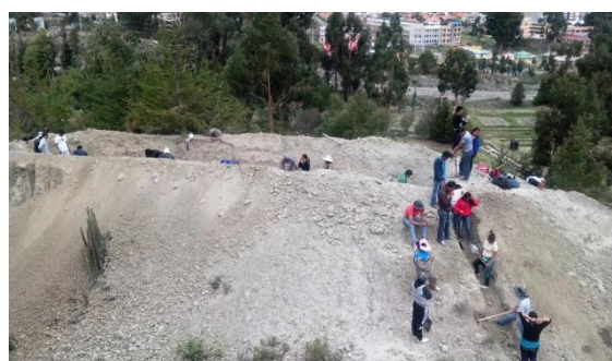
Conclusión del excavado para el reservorio
