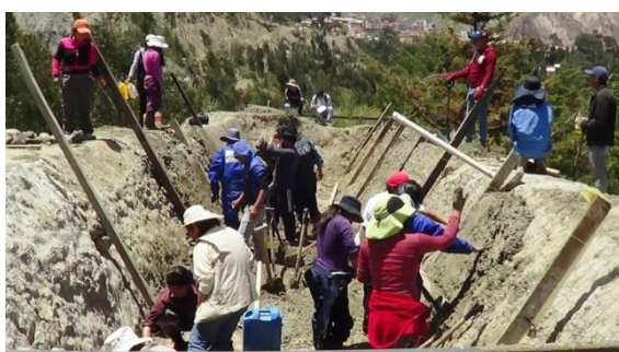
Preparado e inicio de revoque (emparejado)
