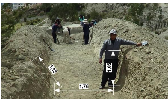
Medidas registradas durante la excavación
