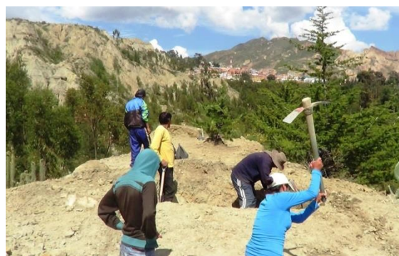
Excavación manual para el reservorio
