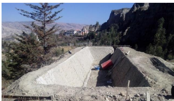
Conclusión de revoque en los taludes
