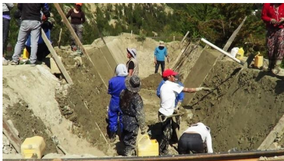
Figura 6. Revocado de los taludes del reservorio con barro.
