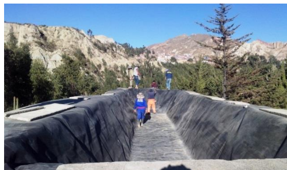
Vista reservorio revestido c/geomembrana
