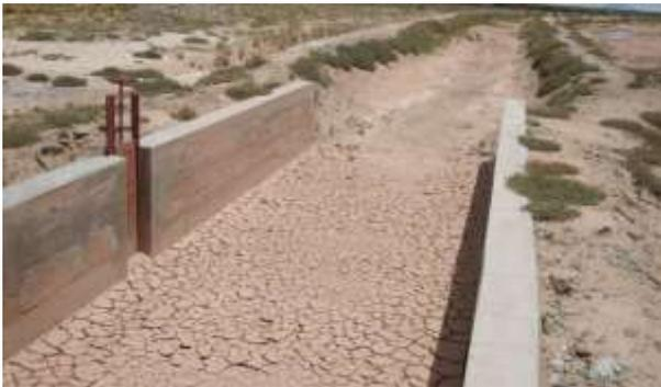
Figura 5. Estado de las compuertas de distribución.
