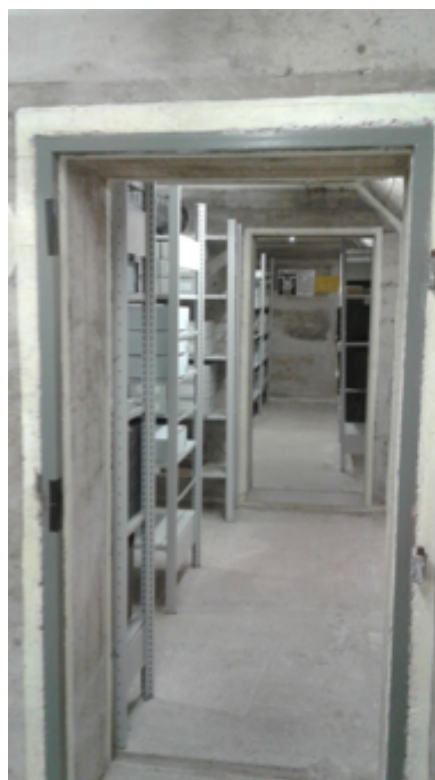
Foto 9: El interior del búnker
