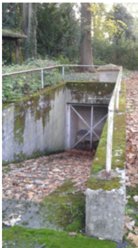
Foto 8: Entrada posterior del búnker
