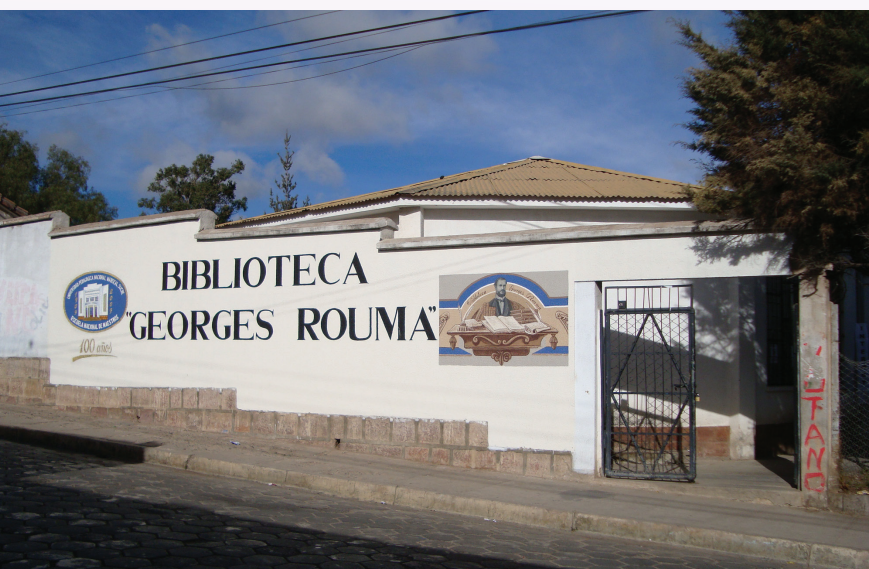
Fachada Principal (calle Cobija N° 98)
