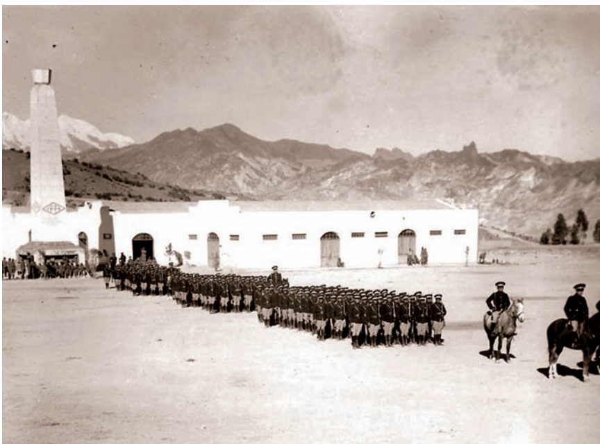
Avenida Saavedra (Hoy gran Cuartel General) Unidad de Carabineros 1934
