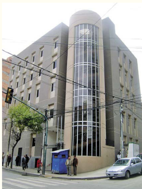
FOTO 7: Frontis del Edificio “Fides Tv”, en la esquina de las calles Jenaro Sanjinés y Sucre.
