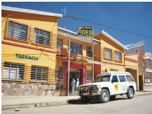
FOTO 4: Frontis de Clínica Fides, en la zona Ballivián de la ciudad de El Alto. Clínica remodelada varias veces desde el año 2006.
