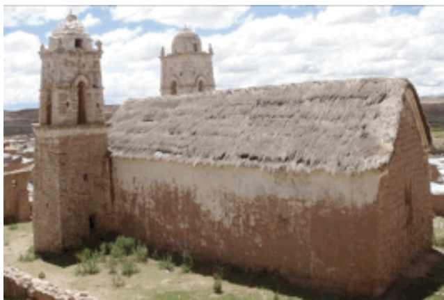
Figura N° 6. Patrimonio arquitectónico “Iglesia de Santa Bárbara” vista lateral
