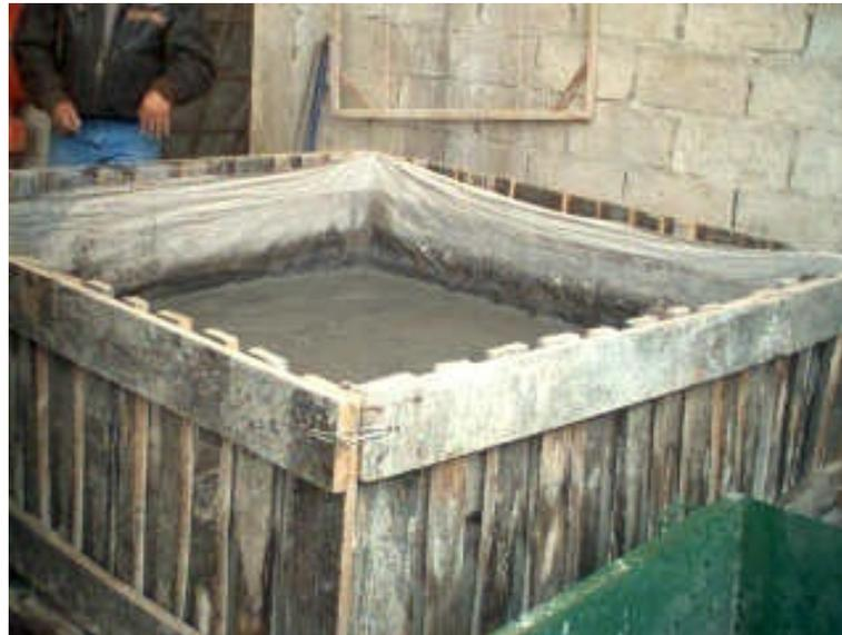
**Figura 5:** Sistema de deshidratación de lodos en la empresa CURMA
