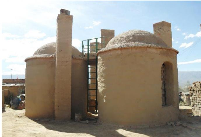
**Figura 4:** Hornos tipo MK3 construidos en adobe, el sistema contempla 3 módulos interconectados para mejorar la eficiencia energética y facilitar la operación del sistema. Por la incorporación de las 3 unidades se denomina a este diseño horno MK3.
