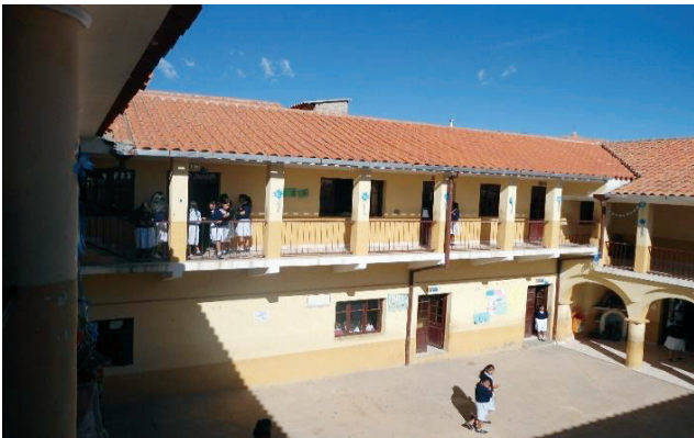
Figura 3. Imagen del área de esparcimiento, correspondiente al patio principal, 2014.
