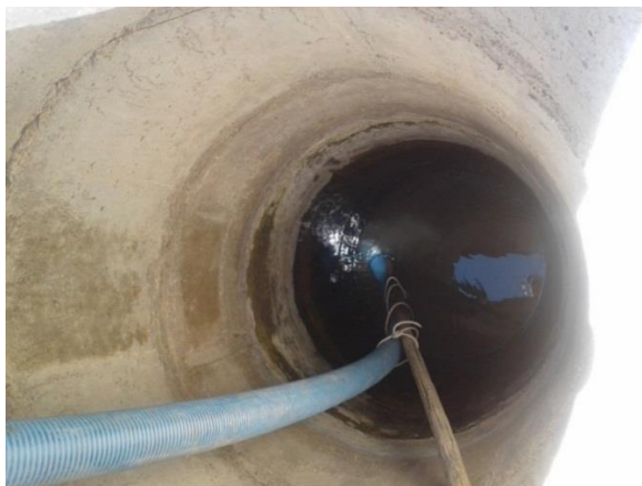
Figura 2. Pozo de observación subsuperficial (Pozo Nro. 2) situado a una altitud de 3757 msnm.
