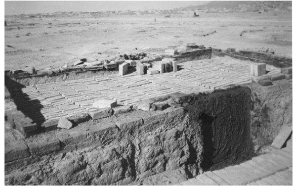
Figura 7. Fotografía del acabado del acomodamiento de los ladrillos, previa a la etapa de cocido
