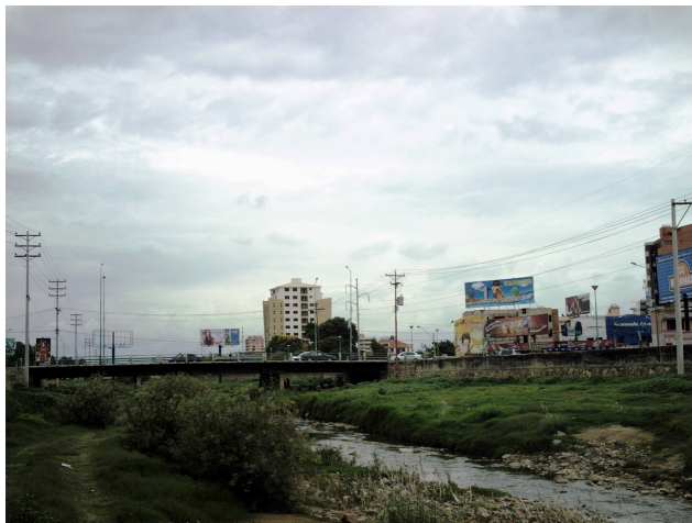
Fotografía 8 Puente de la Recoleta 2008
