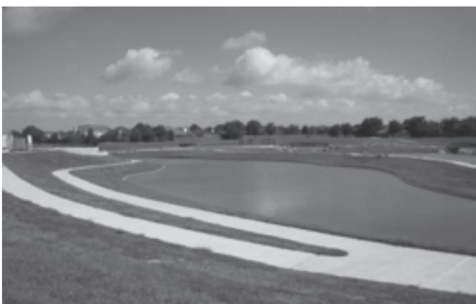
**Figura 10.** Estanques de retención
