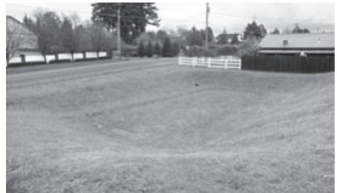
*Depósito de infiltración del tipo embalse superficial*
