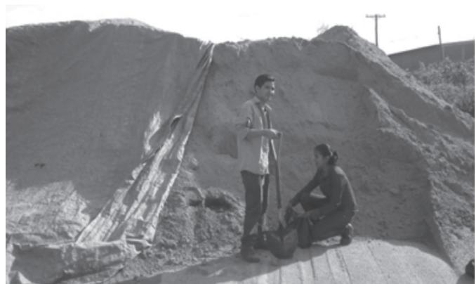
**Figura 7.** Obtención de muestras del acopio de agregados para ser utilizados en las mezclas asfálticas.
