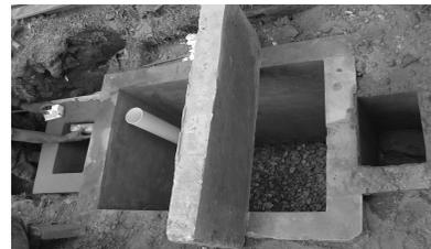
Foto 3 Instalación del tubo para extracción de lodos y tapa
