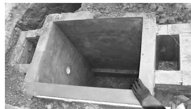
Foto 1 Filtro y cámaras de entrada y salida
