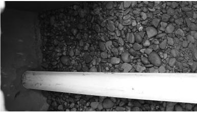
Foto 4 Material de relleno y canaleta colectora
