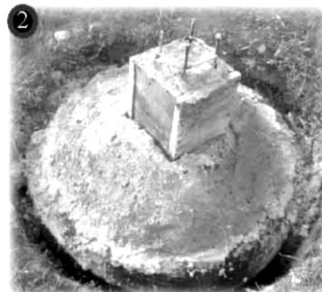
Para comprobar si la zapata era resistente, luego de 28 días (cuando secó el hormigón) se colocó un camión cargado con escombros, que fue elevado con un gato hidráulico, que concentró el peso de la carga en la zapata
