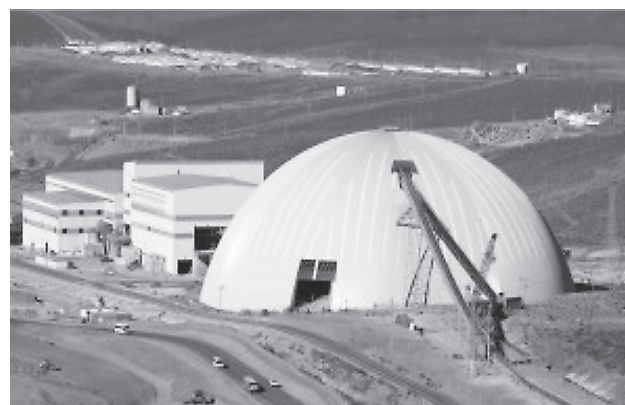
Fotografía 2. Domo metálico conjuntamente se observa el ingreso del material triturado por la parte superior a través de la cinta transportadora. Crédito [6]
