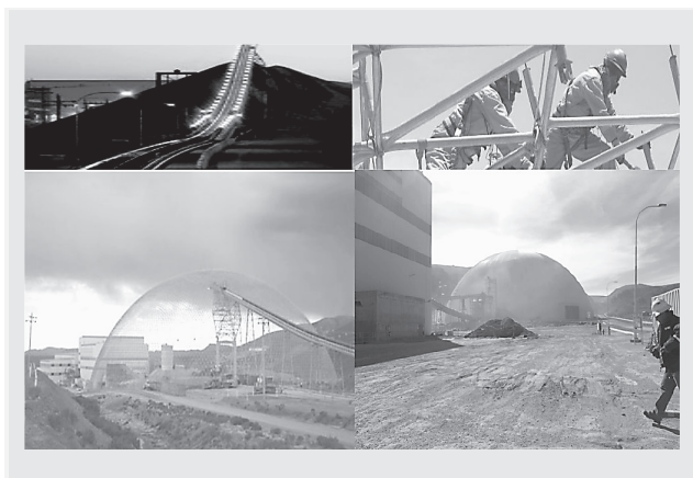
Fotografías 3, 4, 5 y 6. Stockpile descampado y cinta transportadora, armado de la araña, estructura del domo antes y armado estructural (domo de mitigación ambiental) posterior. Créditos [1], [5], [6]
