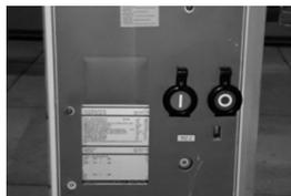
Efectuando en los interruptores pruebas sobre el número de pulsaciones y el funcionamiento del motor-reductor, además de contabilizar las mismas, comparadas con la duración de los carbones respectivos, los datos actuales de cada uno de los interruptores, proporciona que el promedio de pulsaciones corresponde a 280 en 15 meses.
