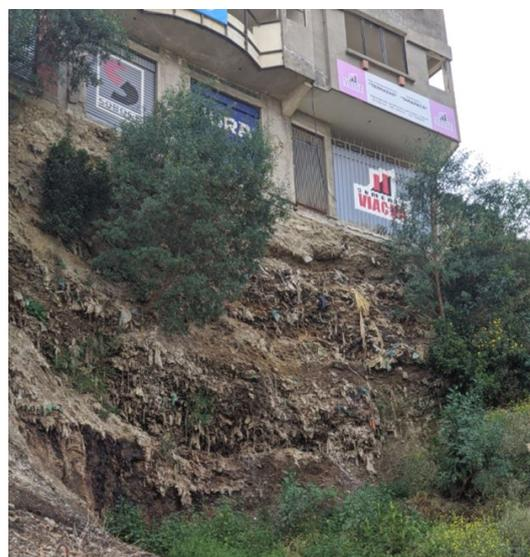
Fotografía 2: Talud con materiales RUS y la vivienda al borde del coronamiento. Crédito: W. Aliaga - S. Paco (2023)
