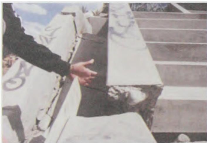
FOTOGRAFIA 3: Desplazamiento de muro de contención
