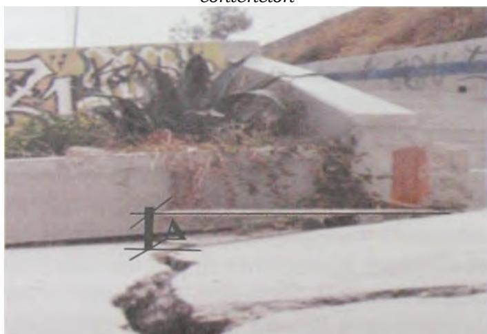
FOTOGRAFÍA 4: Asentamiento y agrietamiento del suelo
