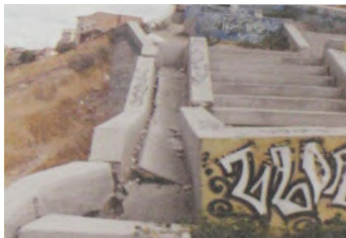
FOTOGRAFÍA 5: Canal agrietado por donde el agua ingresa al relleno
