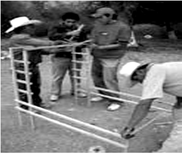
Armado del deshidratador
